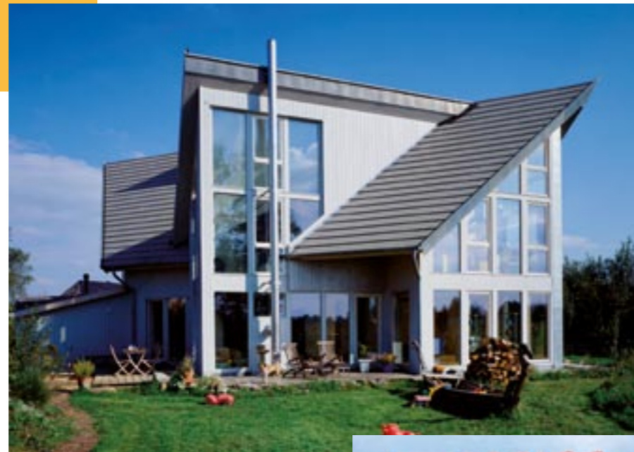
Eine Flachziegel-Eindeckung bewirkt eine sachliche Linienführung
