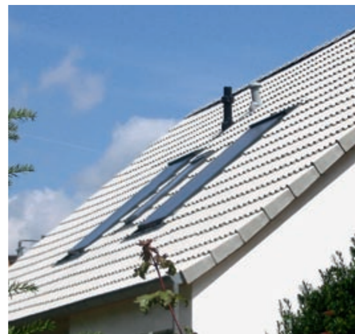
Ein graues Satteldach, das die Luft reinigt: Die Dachsteine beseitigen Schadstoffe aus der Luft.
